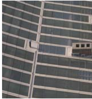
Die homogene Einbindung von allen möglichen Dachgeometrien gelingt mit der Flüssigabdichtung nahtlos.
