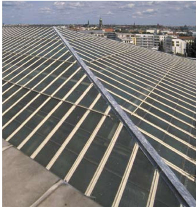
Insgesamt wurden auf einer Länge von 17 Kilometern T-Profile mit Triflex ProDetail abgedichtet.
