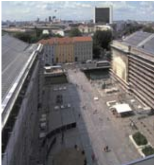
Die mit Drahtglas gedeckten Sattel- und Walmdächer des Pergamonmuseums wurden im Zeitraum 2001 bis 2004 saniert.
